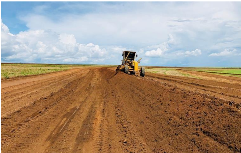
Figura 14 - Motoniveladora fazendo acabamento dos terraços meia base.
