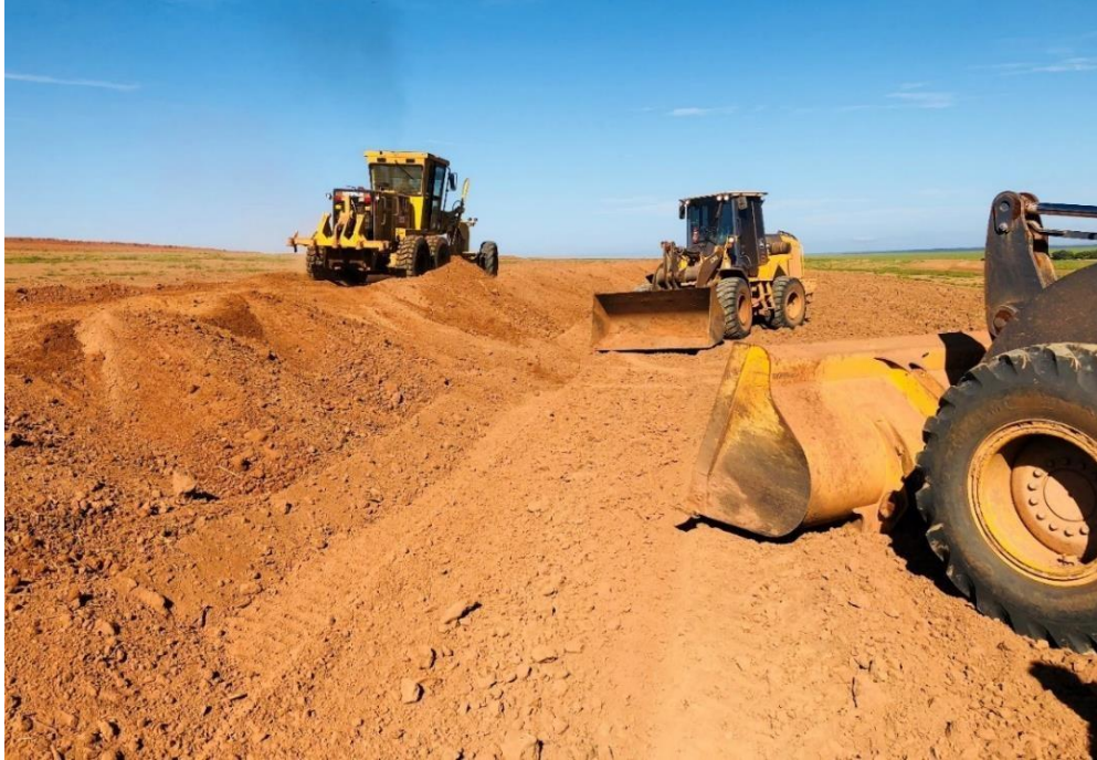
Figura 13 - Pás carregadeiras e motoniveladora.
