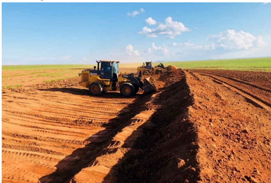
Figura 12 - Pá carregadeira movimentando terra.
